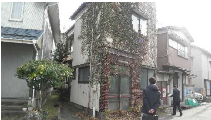
中央区元下島 (解体・除却前)
