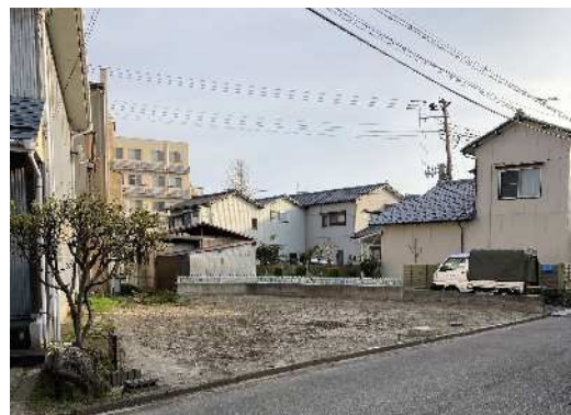
中央区元下島 (解体・除却後)
